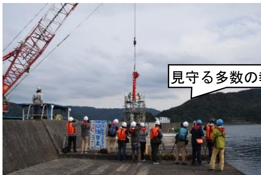
起重機船による灯塔設置
