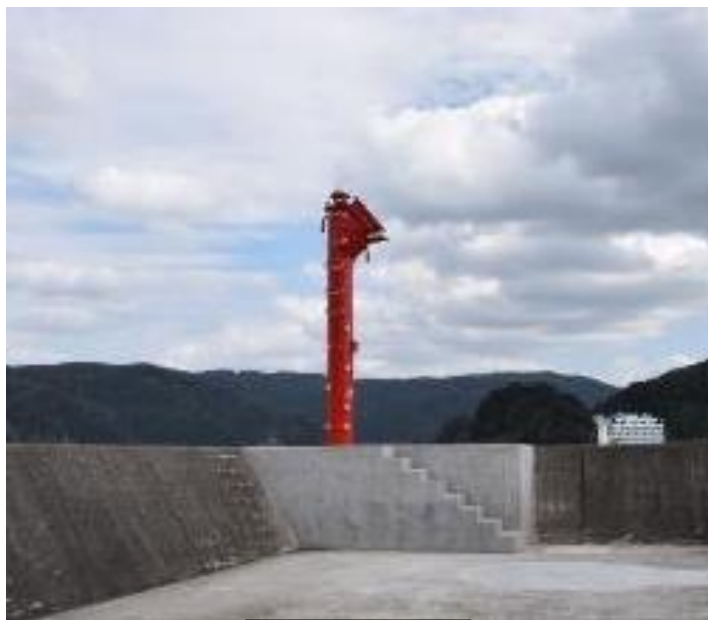
復旧工事完了
